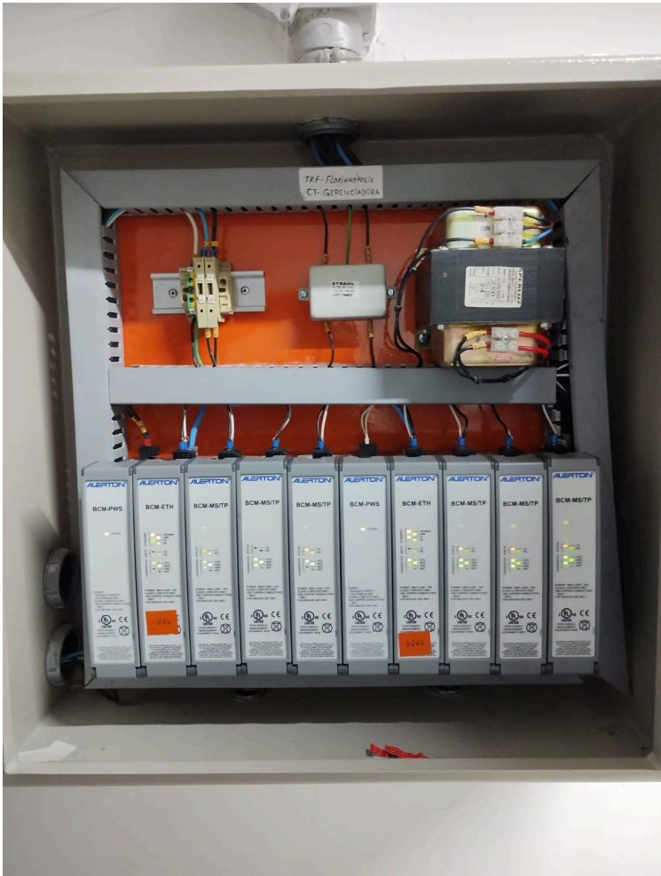
Gerenciadoras Alerton/BCM que devem ser substituídas.
